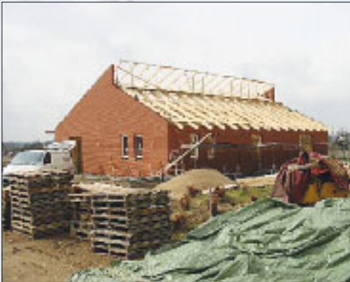
Vandværket under opførelse
