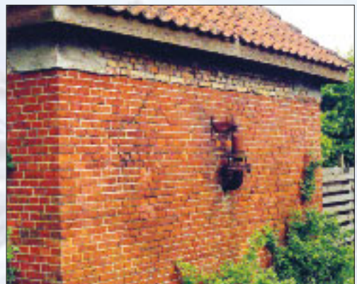
Pumpehuset ved banen
